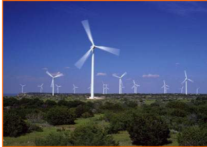
150 MW Trent Mesa, TX
