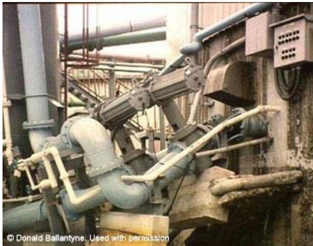
Figura 16-11: Las estructuras que no estaban soportadas por pilotes fracasaron debido a la licuefacción en el terremoto de Kobe en 1995
