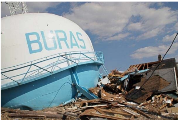
Figura 16-5: Tanque de agua derrumbado en Buras, LA cerca del lugar donde tocó tierra el huracán Katrina [Fuente: FEMA]
