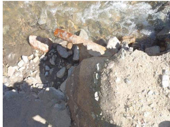
Figura 16-9: Líneas de distribución expuestas (izquierda) y rotas (derecha) debido a las inundaciones en Jamestown, CO [Fuente: Agencia de Protección Ambiental]
