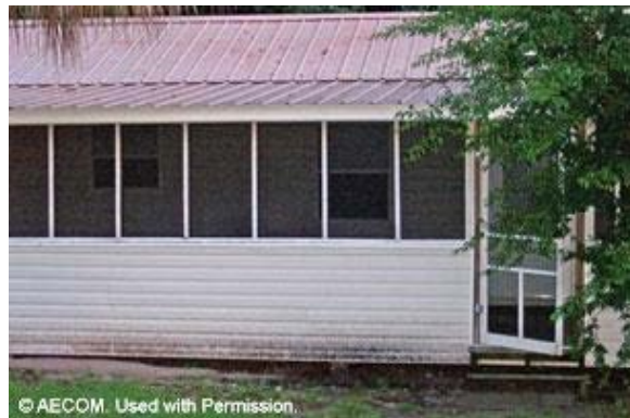
Figura 12-3: Las aguas de la inundación llegaron justo debajo del primer piso de este edificio
