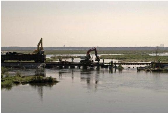
Figura 13-4: Se desgastó un puente ferroviario en Nueva Orleans a causa de las inundaciones durante el huracán Katrina (Fuente: foto tomada por Marvin Nauman [FEMA 2014c])
