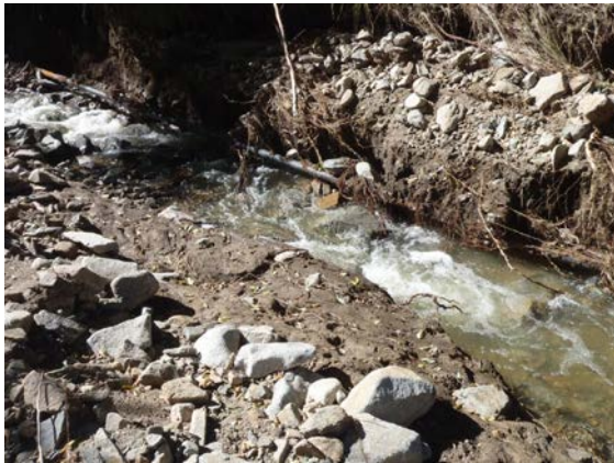
Figura 16-9: Líneas de distribución expuestas (izquierda) y rotas (derecha) debido a las inundaciones en Jamestown, CO [Fuente: Agencia de Protección Ambiental]
