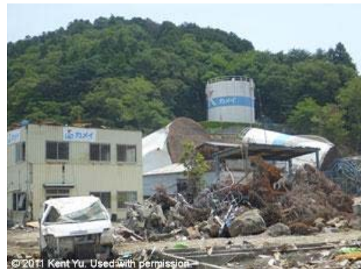
Figura 16-6: Tanques de acero dañados debido al tsunami de Tohoku, Japón en 2011
