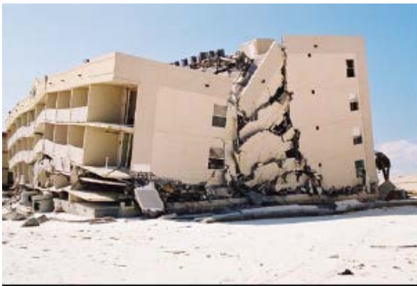
Figura 12-12: Derrumbe de un edificio de cinco pisos debido al desgaste (por inundación) de cimientos poco profundos [Fuente: FEMA]
