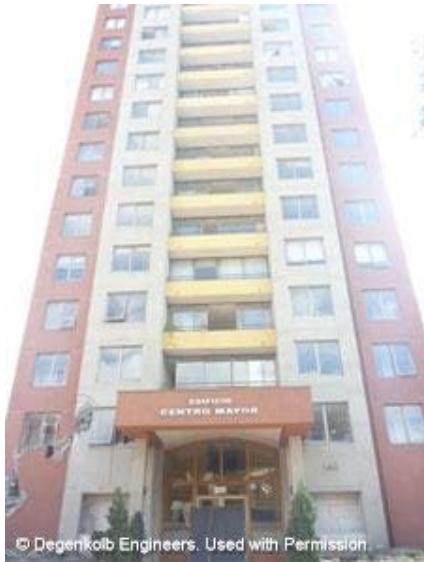
Figura 12-8: Edificio de apartamentos con piezas estructurales dañadas, con una estructura estable
