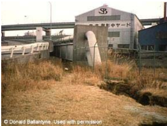
Figura 16-10: Grietas en el suelo (izquierda) y separación de la junta en una tubería de hierro dúctil (derecha) debido a la licuefacción durante el terremoto de Kobe en 1995
